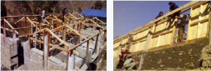
Der Wiederaufbau: Erdbebensicher mit Pfeilern, Grundmauern und Fundament aus Stahlbeton. Die Wände in Holzständerbauweise.
